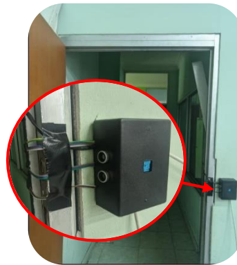
Gambar 14. Implementasi Pemasangan Box B
