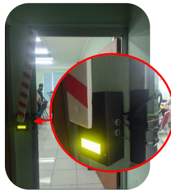
Gambar 13. Implementasi pemasangan Box A
